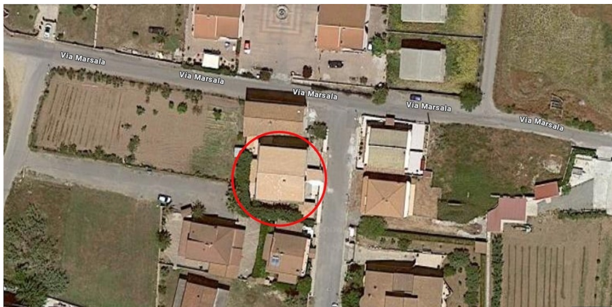
Localizzazione del fabbricato
