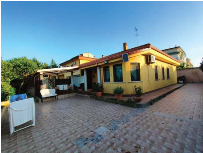
Fig. 8- area pavimentata esterna
