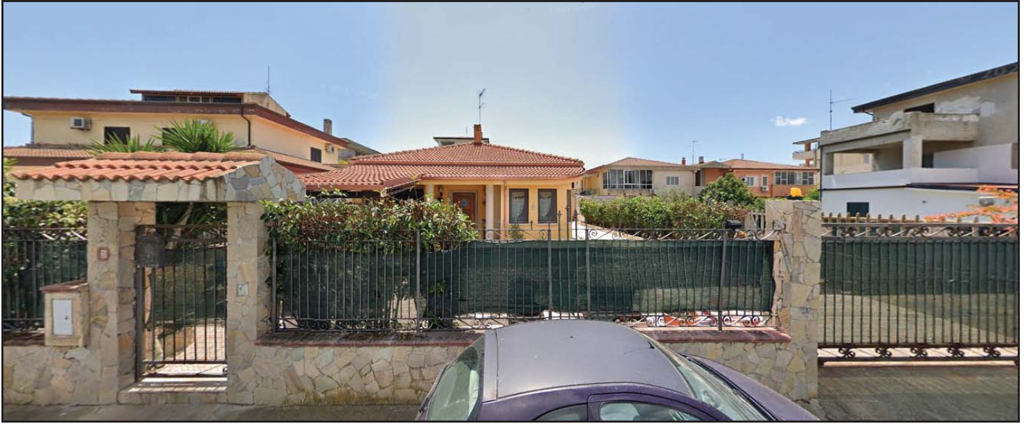
Fig. 3- ingressi (pedonale e carrabile) della villetta
