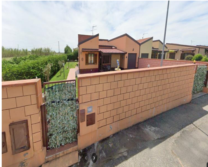
Foto d'insieme della facciata nord adiacente la sede stradale
