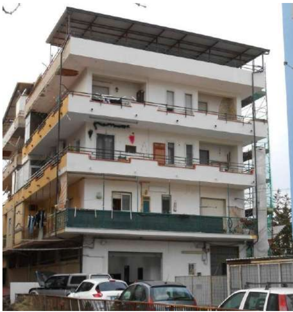
Prospetto del fabbricato di cui fa parte l'immobile pignorato
