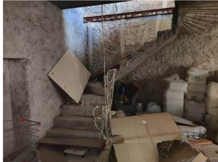
Foto 4- scala di collegamento piano terra - 1° piano
