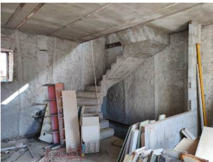
Foto 7- scala di collegamento 1° - 2° piano
