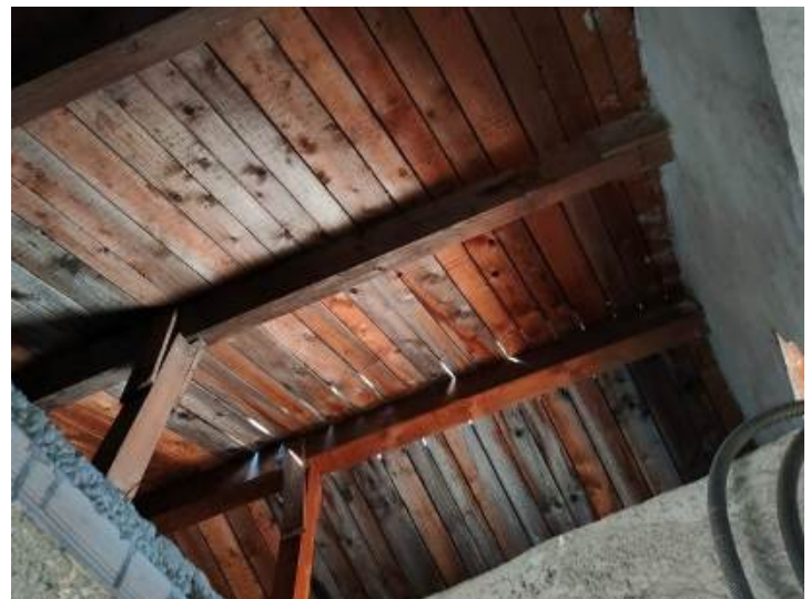
Foto 10- particolare del tetto in legno
