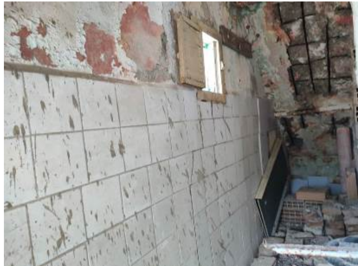
Foto 6- il bagno al 1° piano
