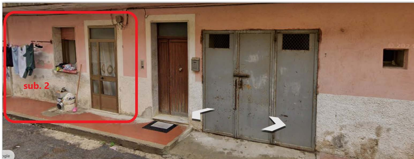
Vista esterna appartamentino sub. 2 - Via Ugo Foscolo
