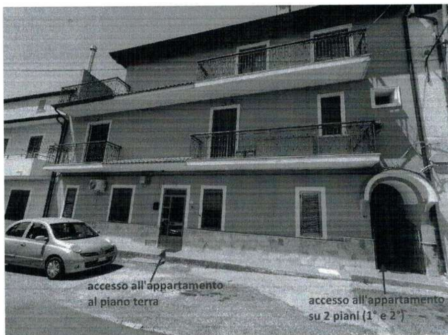
prospetto del fabbricato
