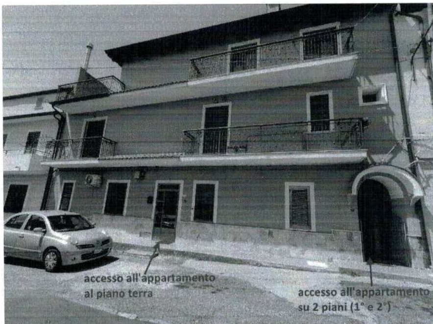
prospetto del fabbricato
