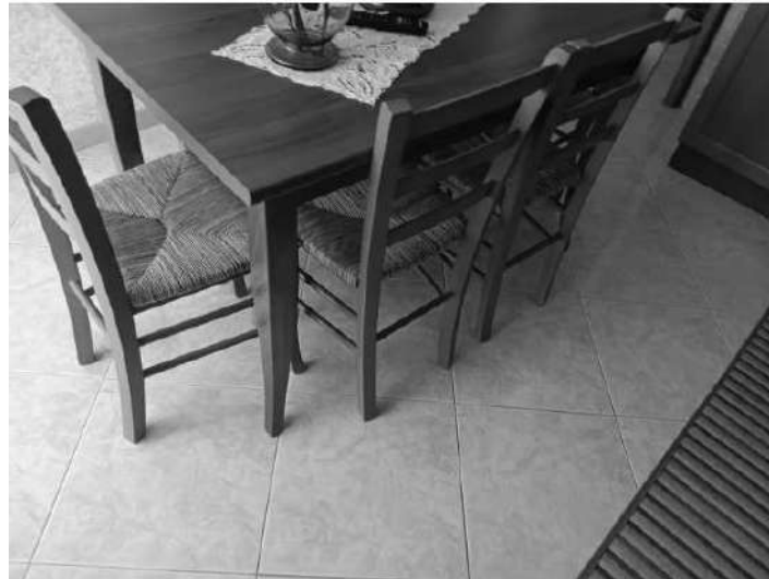
Vista del pavimento della cucina
